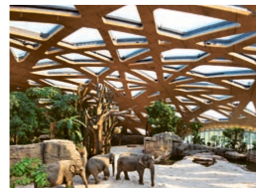
Implenias fertigte beispielsweise das Holzdach für den Elefantenpark im Zoo Zürich.
